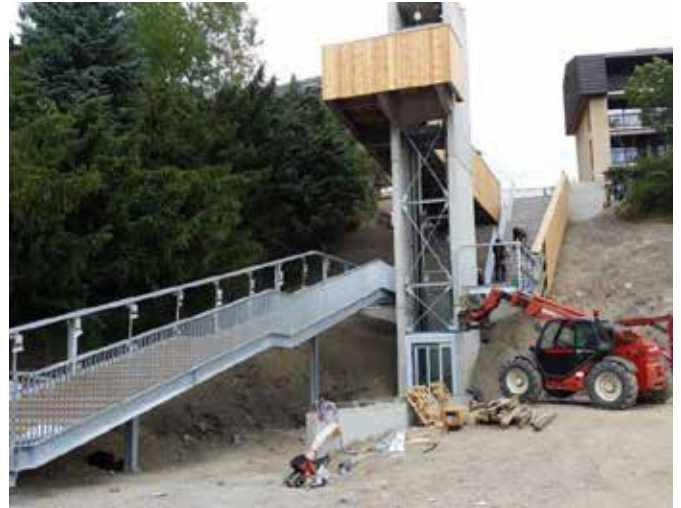
Aménagement du Prorel, Briançon - Sarl Millet
