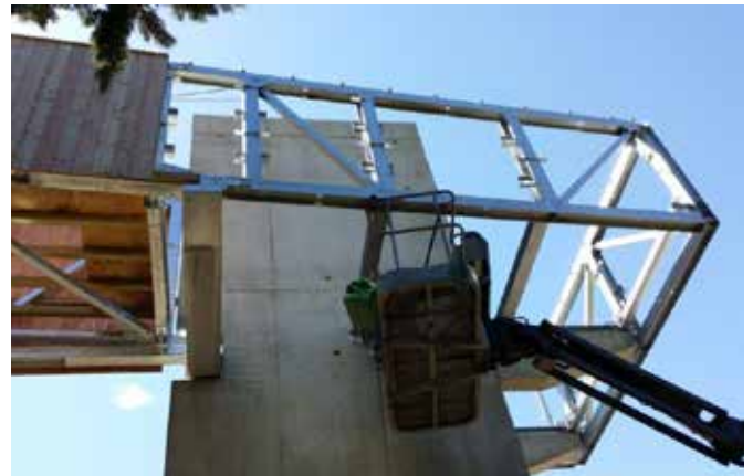
Aménagement du Prorel, Briançon - Sarl Millet
